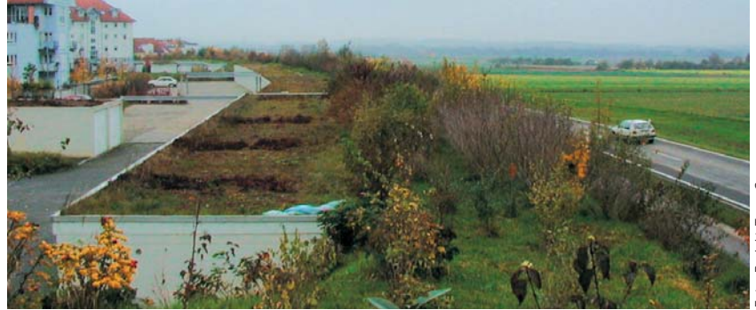
Garagen mit vorgelagertem Erdwall als Schallbarriere.
